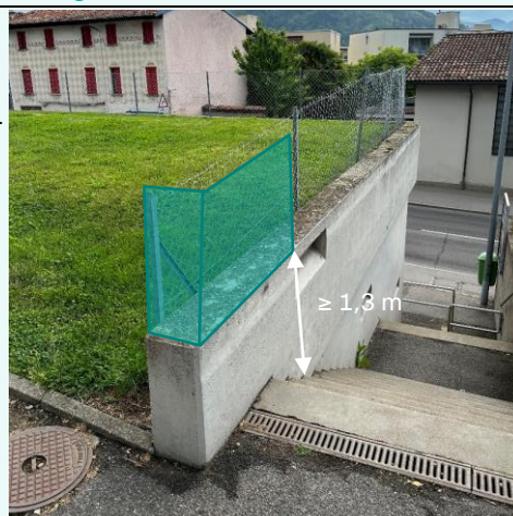
Figura 20 Possibilità di risvoltare la recinzione
