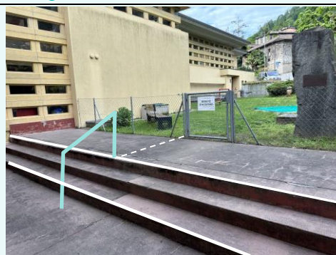
Figura 32 Corrimano allineato sul passaggio
