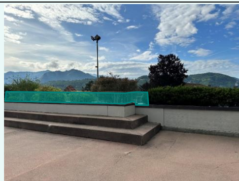
Figura 24 Possibilità di protezione non arrampicabile
