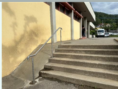
Figura 15 Rampa adiacente la scala
