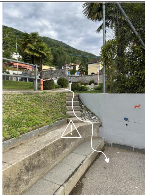
Figura 8 Scala incompleta
