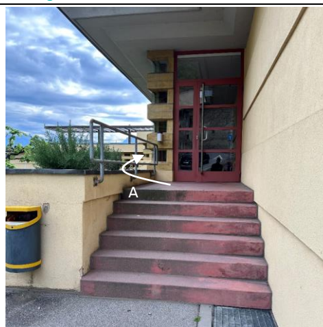
Figura 25 Barriera arrampicabile e scavalcabile
